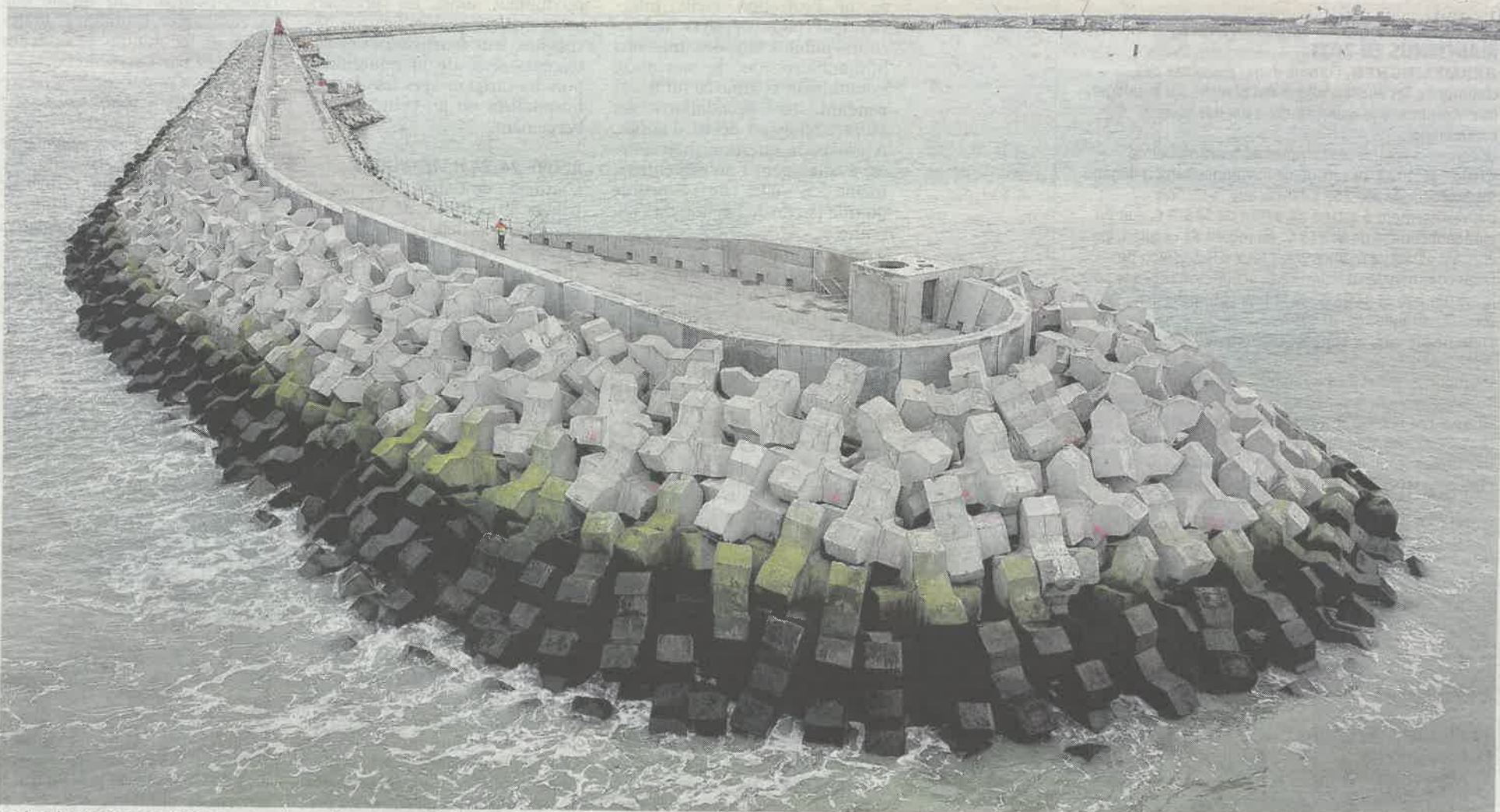
Le chantier de Calais port 2015 comprend une digue de plus de 3 km. PHOTO JOHAN BEN AZZOUZ
