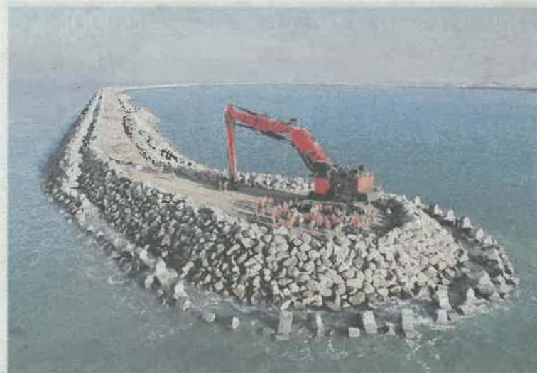
L'impressionnante digue, vue du ciel.
