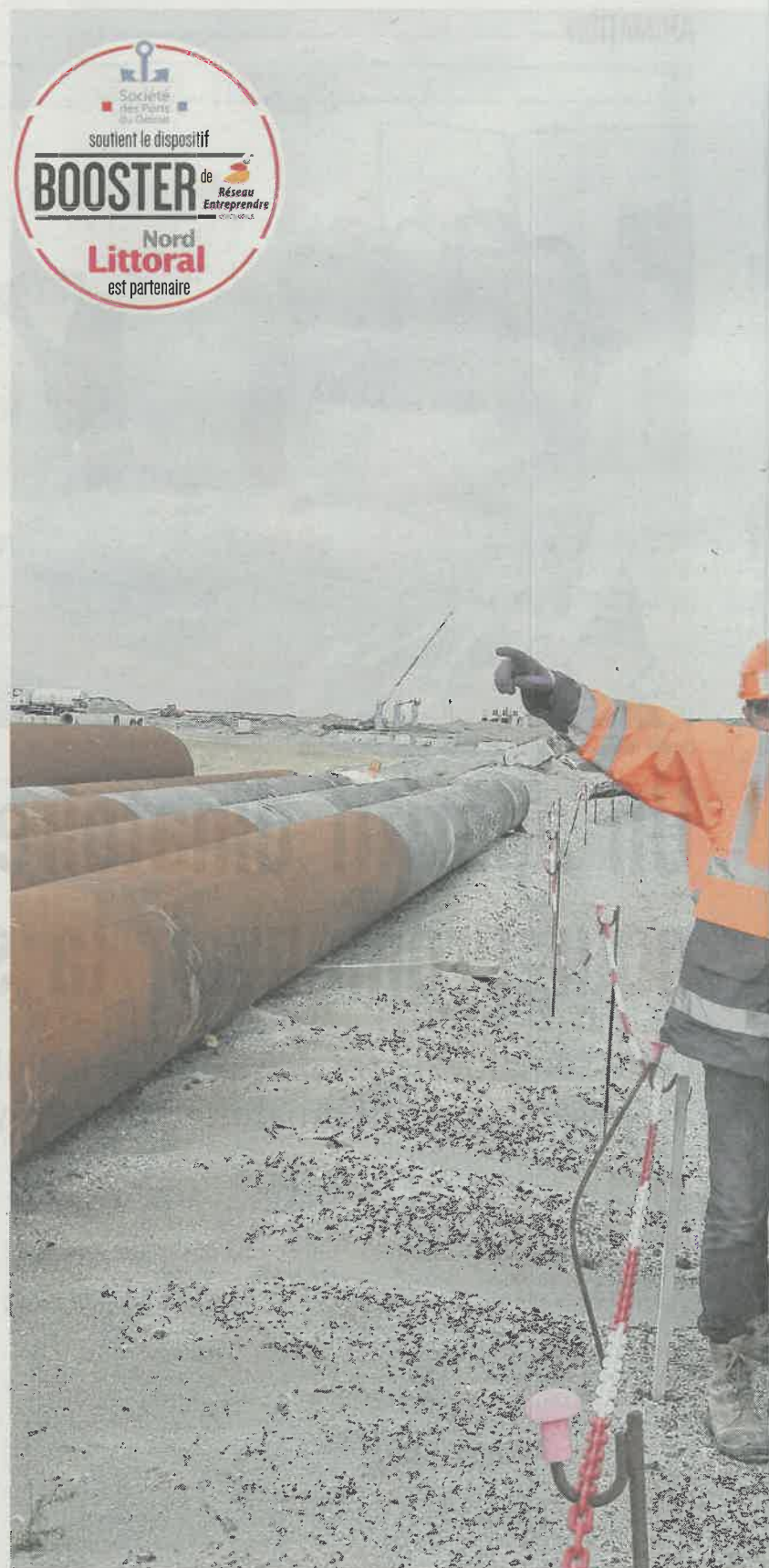
Lors de cet atelier, les participants ont visité le chantier avec Eric Duriez, responsable maîtrise Calais Port 2015.
