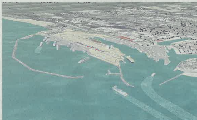
L'absence de « grosses tempêtes » a permis la bonne avancée du chantier.
