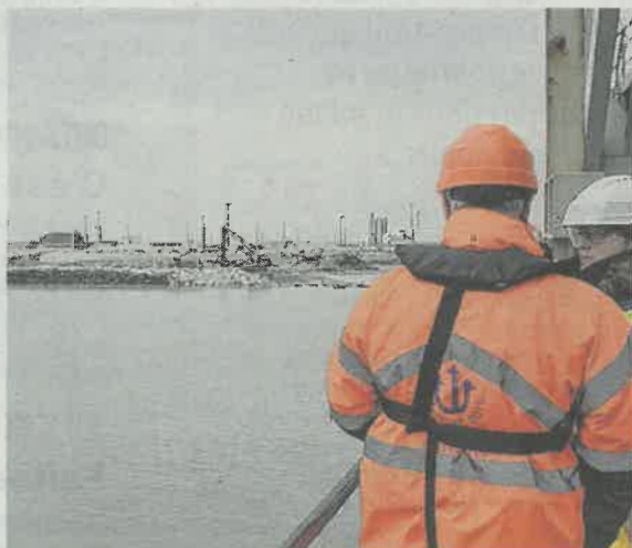
Malgré un démarrage retardé, le chantier est aujourd'hui dans les temps.
