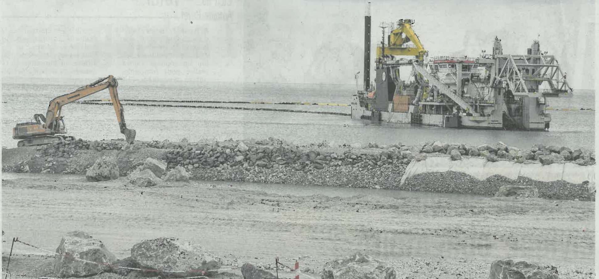
Depuis mi-mars, la drague creuse et aspire le fond pour rejeter sable et eau quelques centaines de mètres plus loin, pour permettre de construire un terre-plein de 45 hectares gagné sur la mer.
