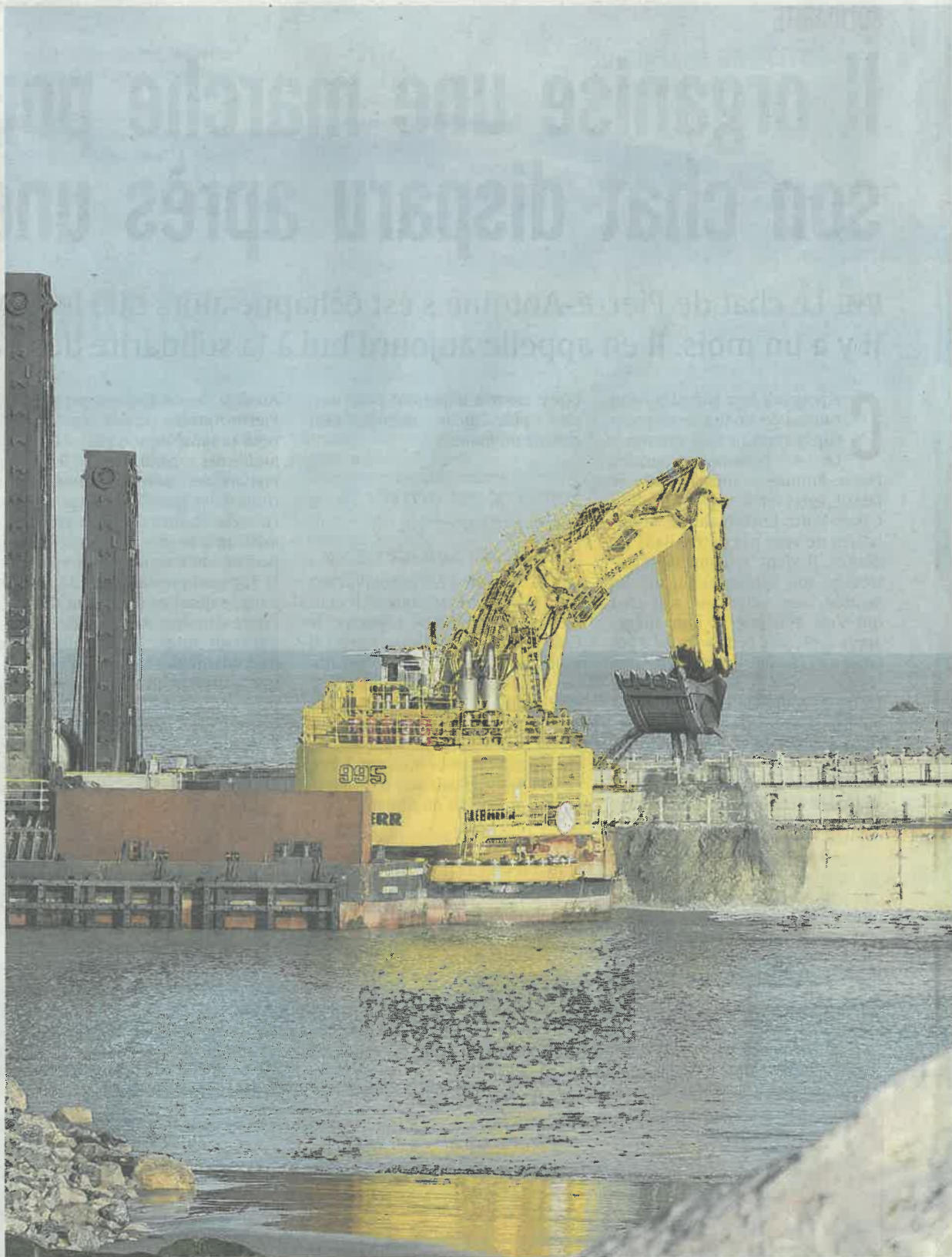
Les visiteurs ont pu observer plusieurs aspects et métiers du chantier de Calais Port 2015.
