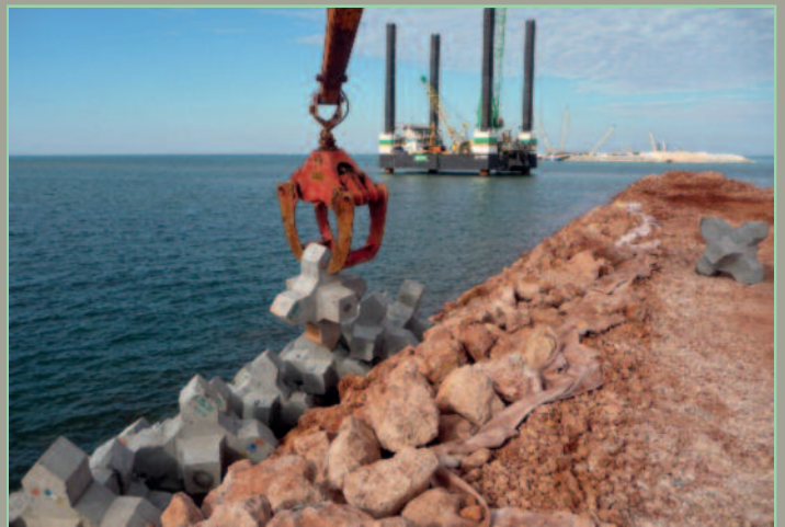
Digue Gorgon, West Australien
